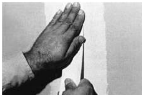
Fig. 45 Sellado de junta con masilla y cinta de papel
