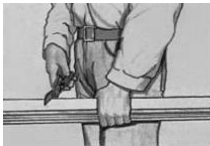
Fig. 37 Corte de estructura metálica.
