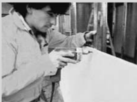
Fig. 42 Corte de placa. Quiebre del núcleo de yeso.
