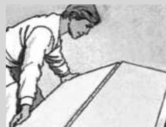
Fig. 42 Corte de placa. Quiebre del núcleo de yeso.
