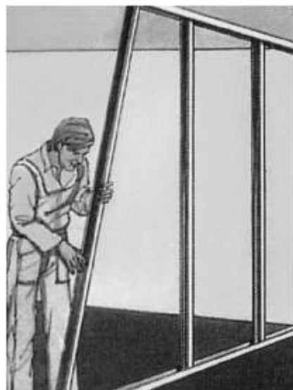
Fig. 38 Armado de estructura metálica.
