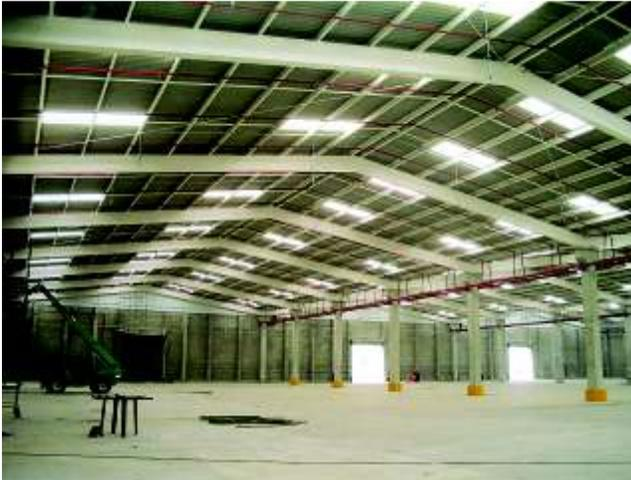
Perfil de Policarbonato es la plancha ondulada rígida de alta calidad que se caracteriza por su elevada resistencia contra impactos, transparencia, ligereza y versatilidad. Cuenta con un 90% de policarbonato transparente que es ideal para acristalamiento de techados en edificios industriales, agrícolas y de entretenimiento. Resulta fácil de instalar y manipular.
