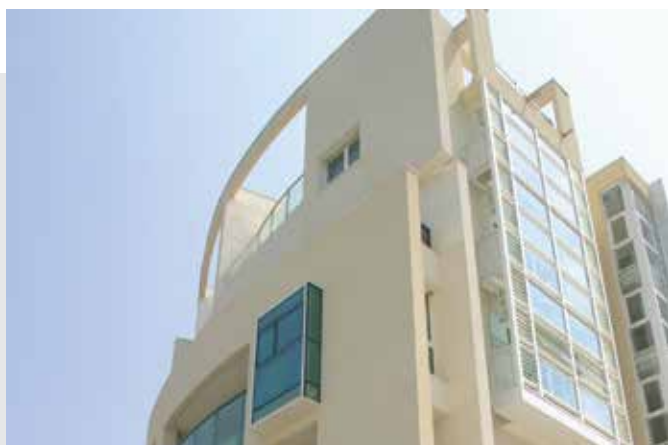
Viviendas residenciales, Senigalia, Italia
