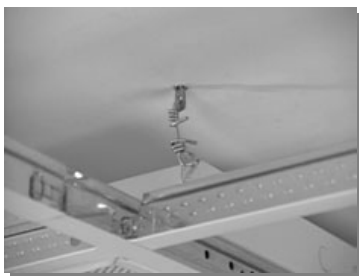
La suspensión puede requerir colgantes adicionales para sujetar el peso de los artefactos de iluminación
