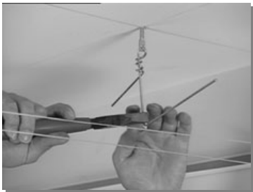
Doble los alambres del colgante a la altura de la cuerda guía
