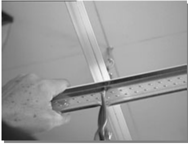
Instale las "T" secundarias del borde
