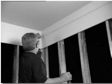
Marque la altura deseada para el nuevo techo
